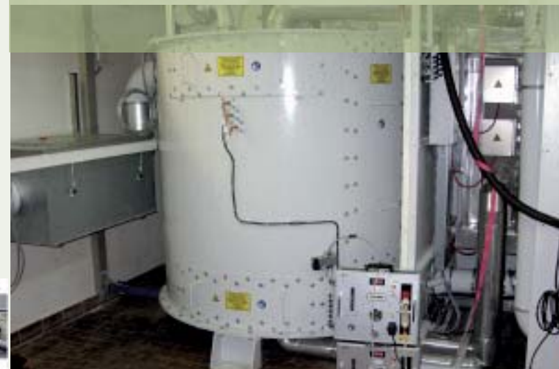
Abluftreinigungsanlage, mit ZEOcat Z-400 gefüllt
